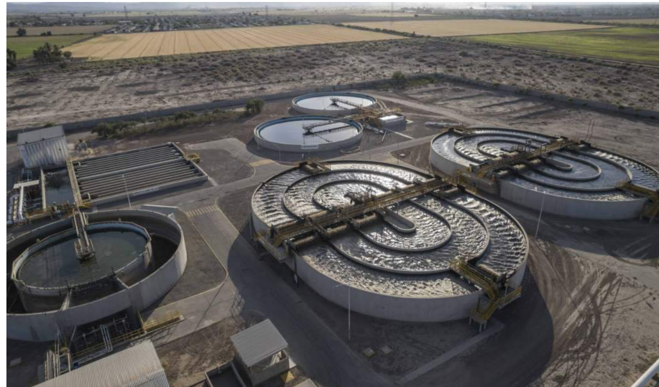
Planta de tratamiento de agua en La Rosita
